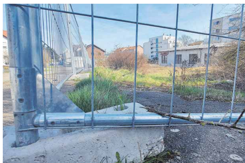
Noch ist auf dem Gelände nicht viel zu sehen.
